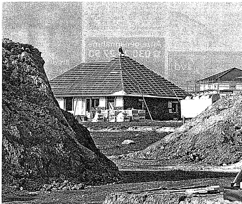
Neubaubereich: Grundeigentümer müssen sich mit Abgaben an Infrastrukturmaßnahmen beteiligen.
